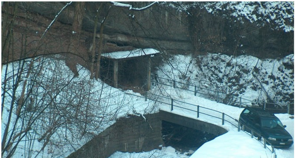
Brücke über die Steinach, Mühltobel, 9000 St. Gallen (Photo: Gil Huber)
